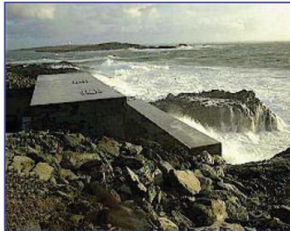
Figura 4.13.- Dispositivo Limpet.
