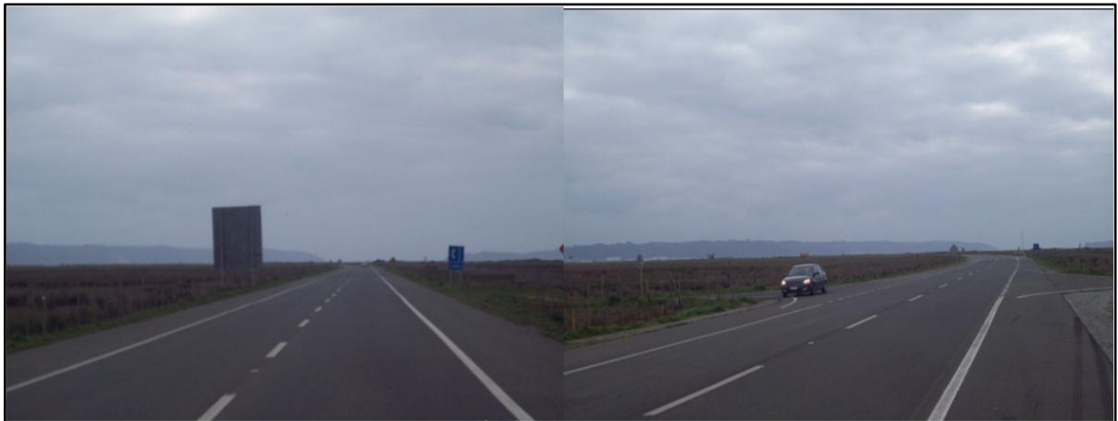
Figura 3. Tramo de Prueba. Ruta Interportuaria, entre Km 5.0 y 7.0
