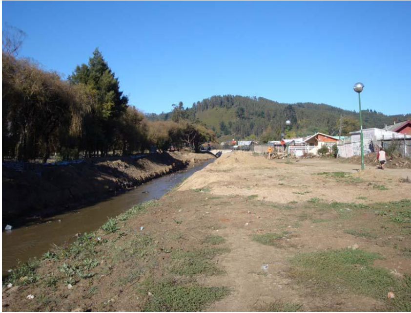
FiguraH28. Estero Nonguén, Villa Loncopán. Se observa que las casas de Villa Loncopán están a escasa altura con respecto al Estero Nonguén, lo cual la predispone a sufrir inundaciones durante crecidas invernales.
