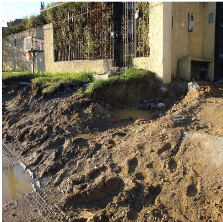
FiguraH11. Barrio Lomas de San Andrés, calle Alonso García de Ramón, casa No 275. Se observa hundimiento de la vivienda y del suelo del patio. Nótese las plantas hundidas más de 40 cm respecto a la vivienda.
