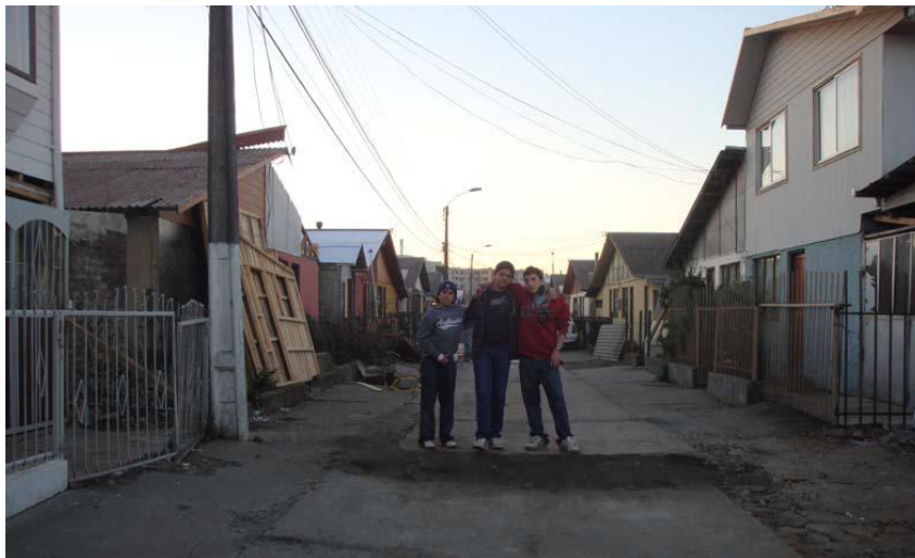
FiguraH34. Población Buena Vista, Pasaje 4. A los pies del grupo de jóvenes se observa grieta que atraviesa la calle, ya cubierta por los vecinos, nótese el desplazamiento vertical de la misma, así como el descuadre de las rejas.
