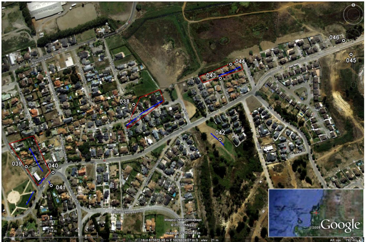
FiguraH6. Sector Lomas de San Andrés. Polígonos rojos indican los sectores visitados con grave daños de viviendas, en azul se ilustran grietas principales que afectaron calles y viviendas y los círculos rojos indican los sectores donde ocurrieron “golpes de agua”. Los puntos 43 y 44 corresponden al sector Barrio Los Españoles.
