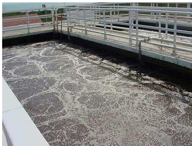
Figura 3.8.2.1- el proceso de fango activado, tanque de aireación de una instalación de fango activado en una planta metropolitana de tratamientos de aguas, el tanque tiene 30 metros de largo, 10 de ancho y 5 de profundidad.
