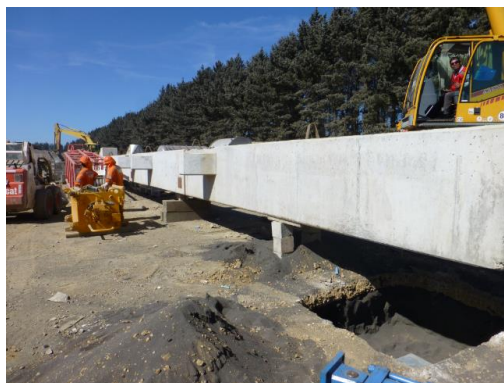
Figura 6: Disposición inicial de la columna y sistemas de apoyo (CITEC UBB)
