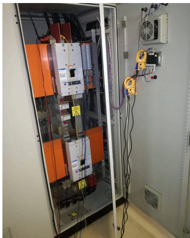
Figura 4.2: “Conexión del analizador al tablero principal.”
