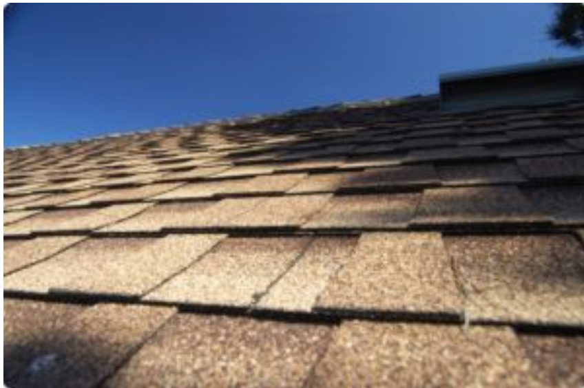
Figura 13. Centro de investigación y alcance de incendios. Tejas de asfalto de fibra de vidrio
