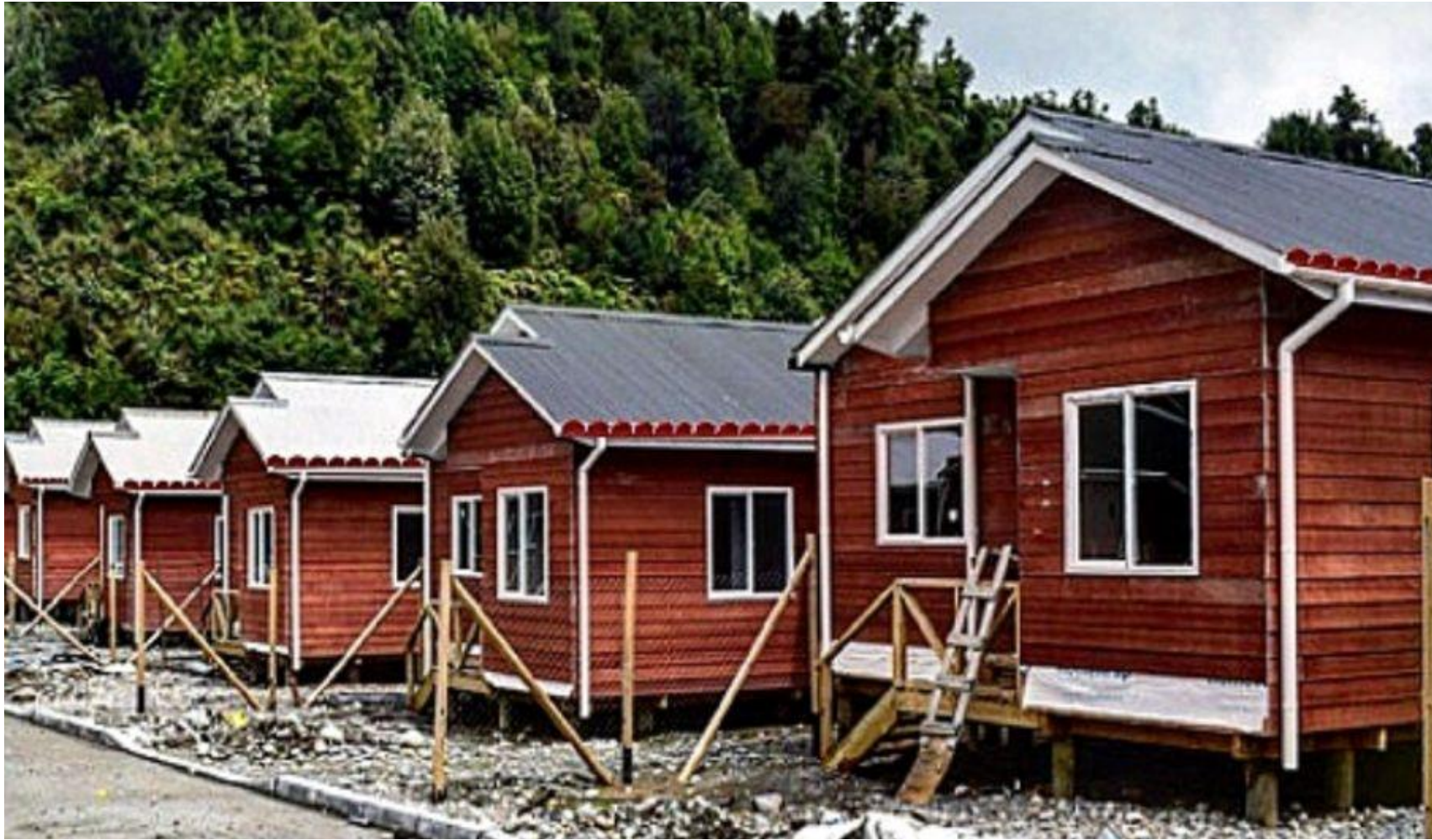
Figura 24. Fotomontaje que muestra viviendas sociales cercanas a zonas vegetativas, con faldones instalados en sus canaletas
