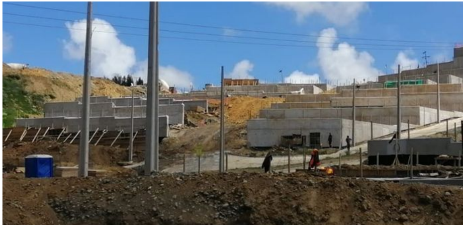
Figura 17. Emol. muros de hormigón como protección de incendios forestales
